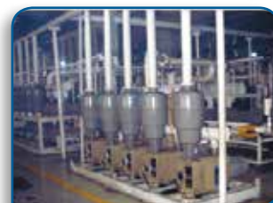
Helowy test szczelności
